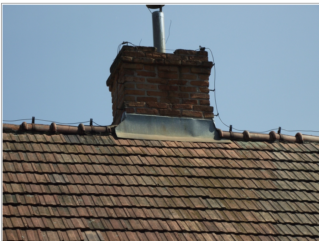
fot. nr 17 - Komin wraz z obróbką blacharską wokół.
