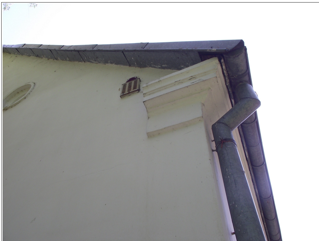
fot. nr 18 - Wiatrownica, podbitka, rynna oraz rura spustowa.
