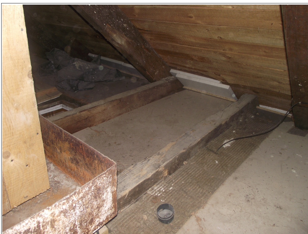
fot. nr 12 - Więźba i strop nad 1. piętrem w starej części budynku.
