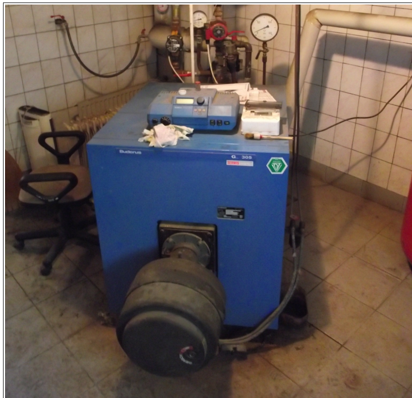
fot. nr 6 - Kocioł olejowy usytuowany w piwnicy.
