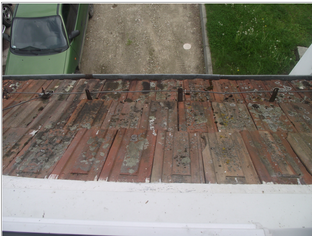
fot. nr 16 - Istniejąca dachówka ceramiczna i instalacja odgromowa.
